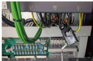
圖7 電流實際量測位置
